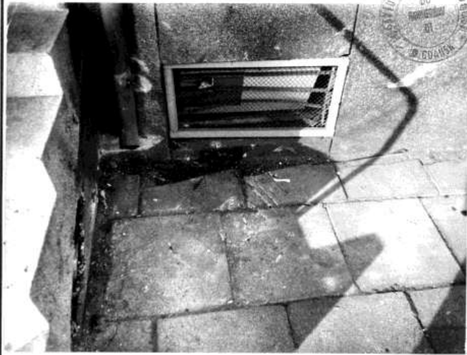
ZNISZCZONE PŁYTY CHODNIKOWE PRZY SCHODACH WEJŚCIOWYCH 445151A
